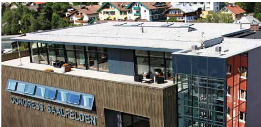
Auf dem Dach des Congress Saalfelden soll künftig Sonnenstrom produziert werden.
